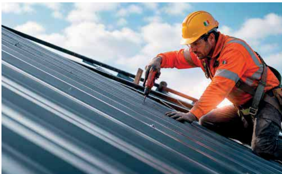
Copertura in lamiera gregata
