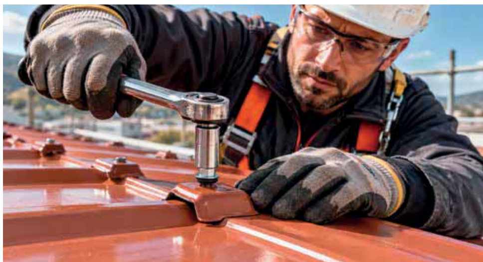
▲ Serraggio manuale su tetto metallico
