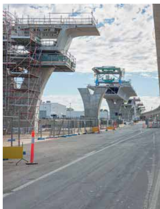
▲ Parapetti e ponteggi sospesi
