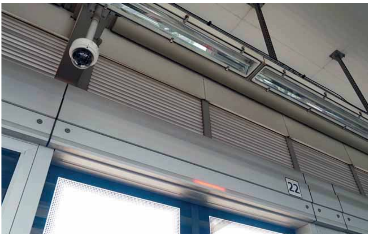
▲ Installazione canaline industriali
