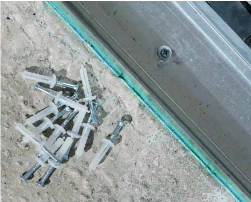
▲ Installazioni profili per struttura in cartongesso
