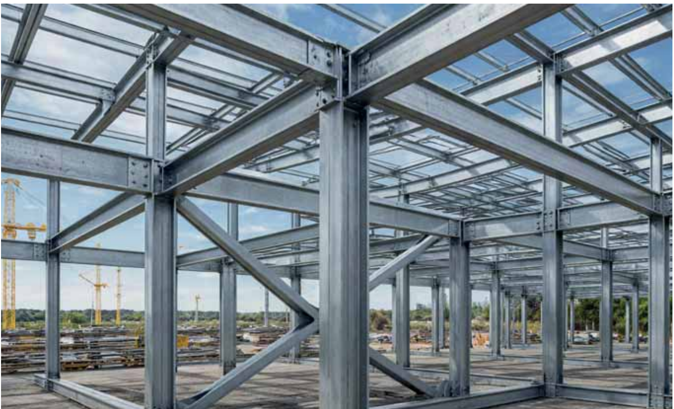
▲ Utilizzo su travi d'acciaio e carpenteria metallica
