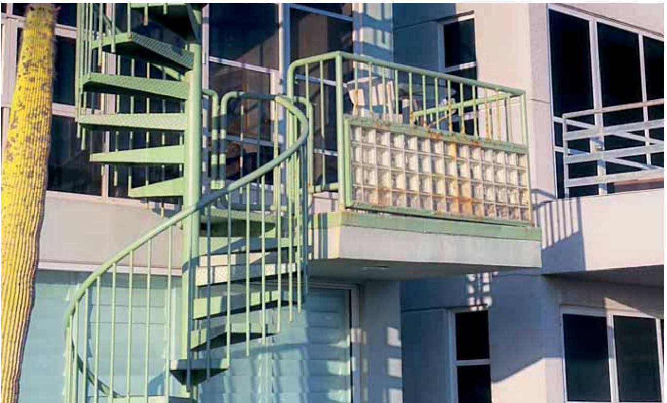
▲ Installazione di scale e parapetti
