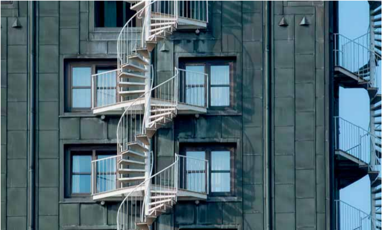
▲ Installazione di scale antincendio
