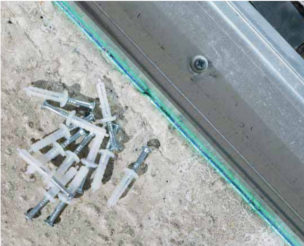
▲ Installazioni profili per struttura in cartongesso
