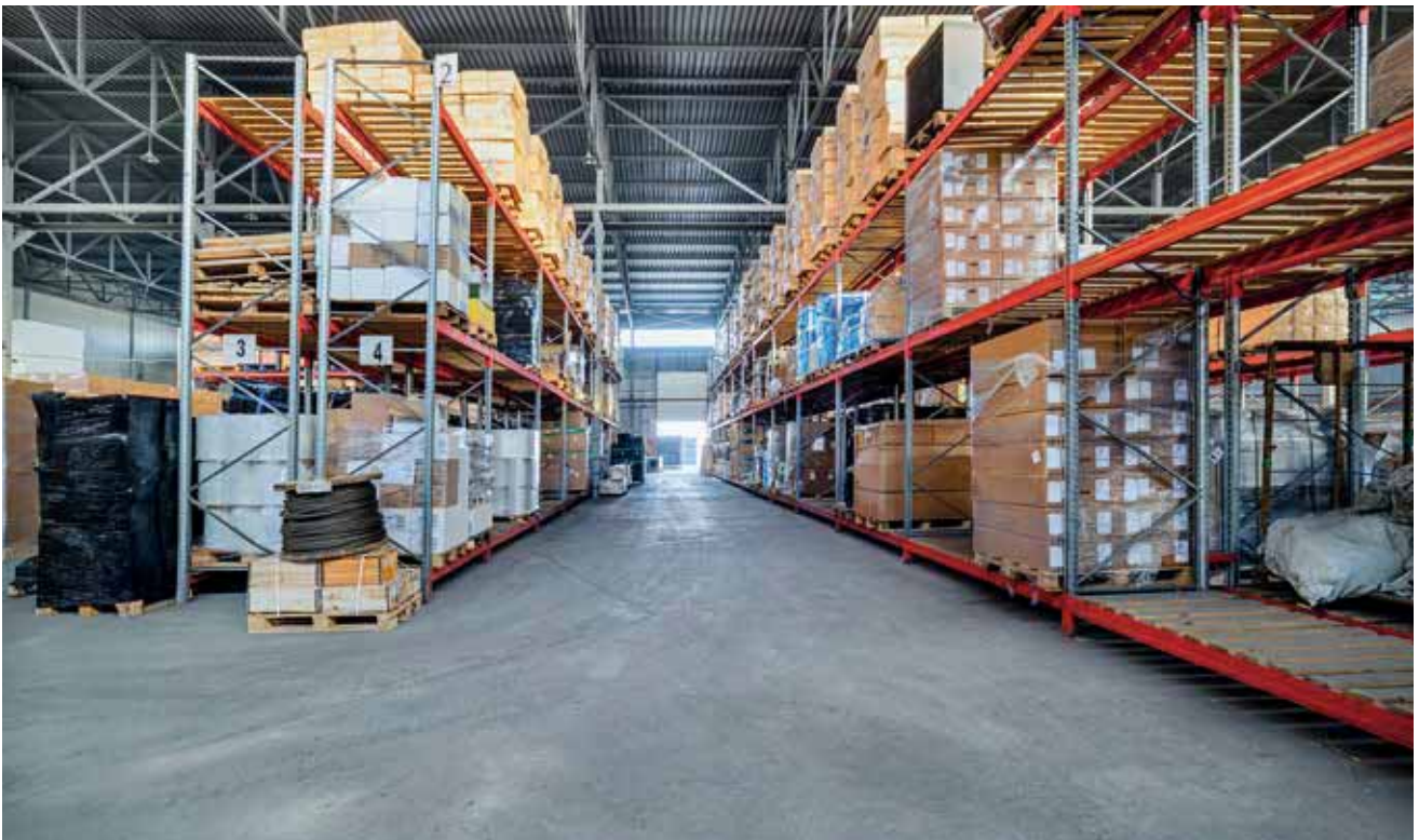
▲ Installazione di scaffalature industriali
