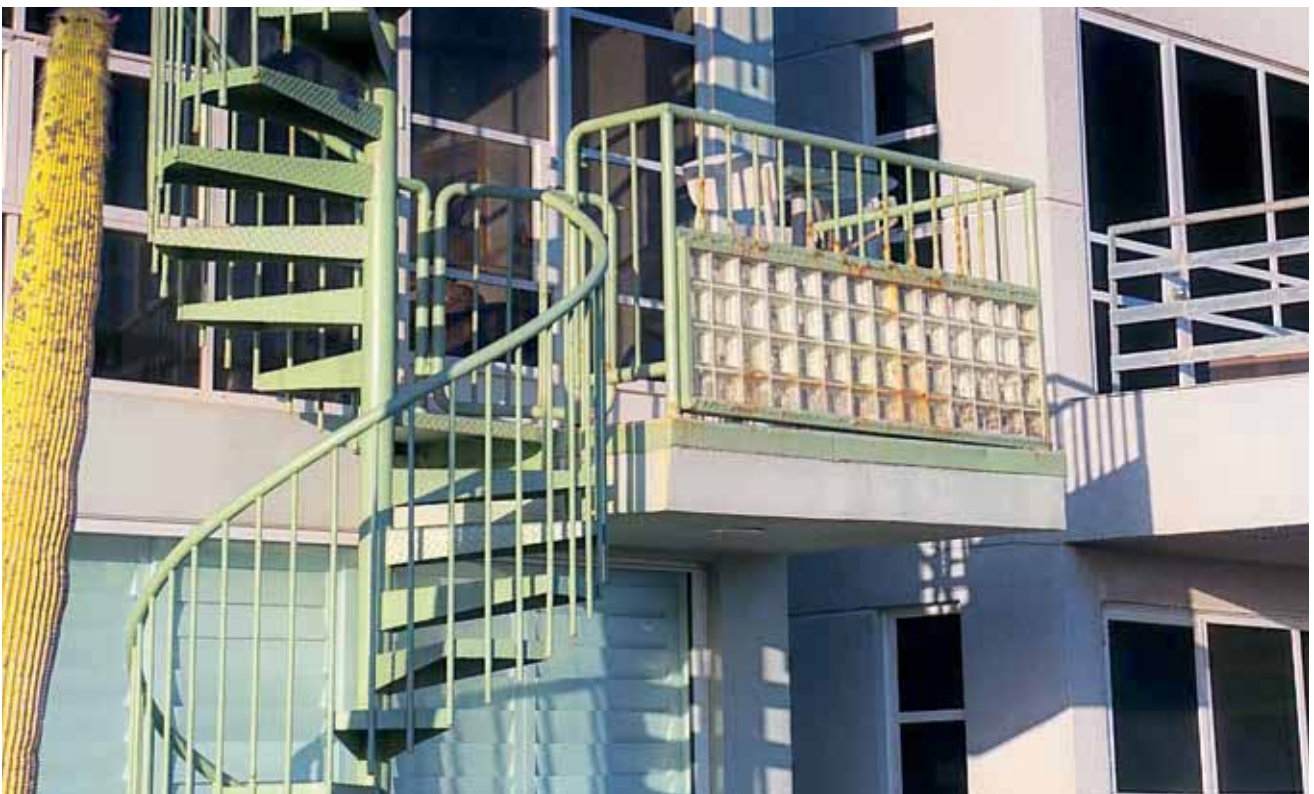
▲ Installazione di scale e parapetti
