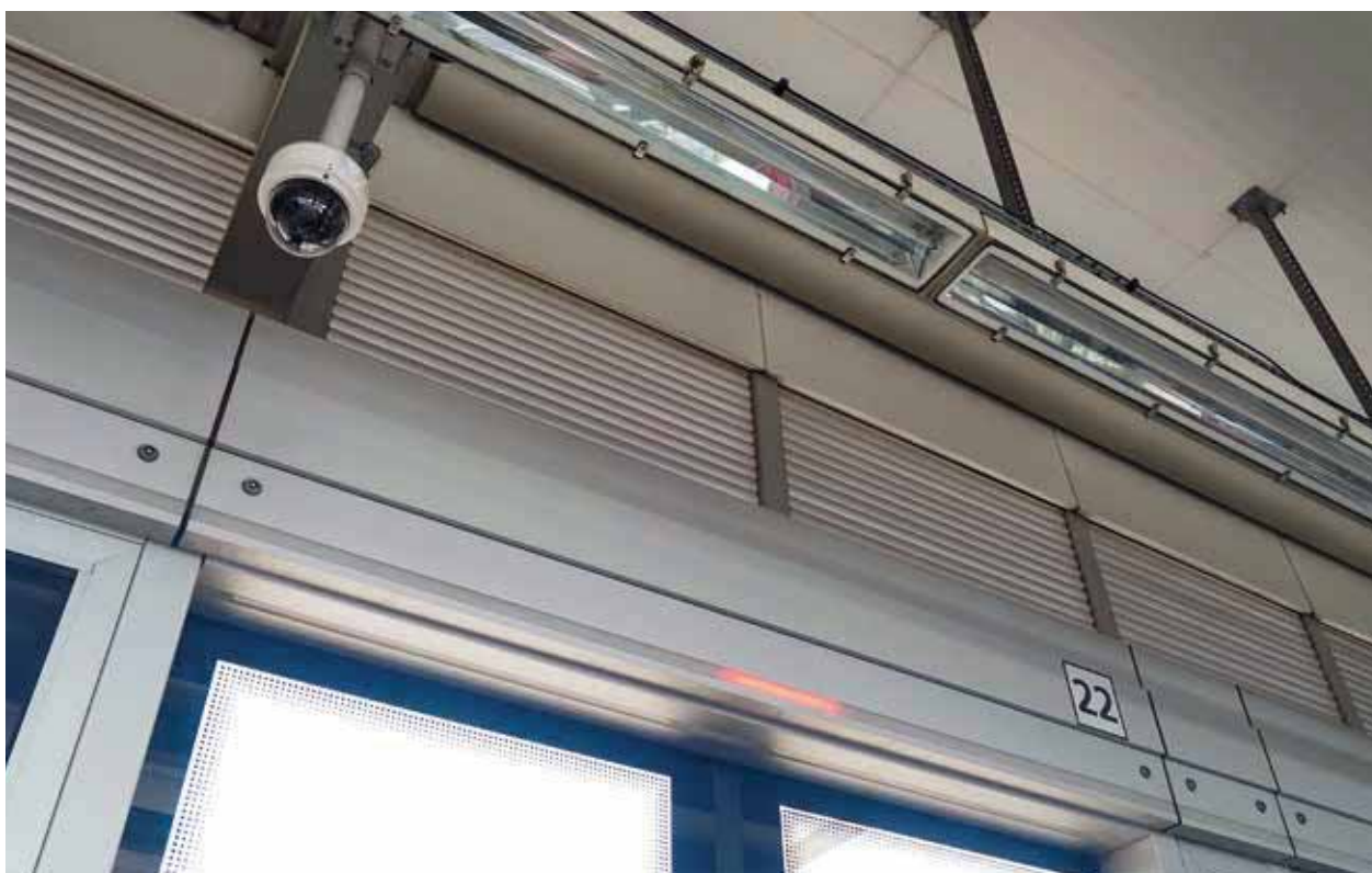
▲ Installazione canaline industriali
