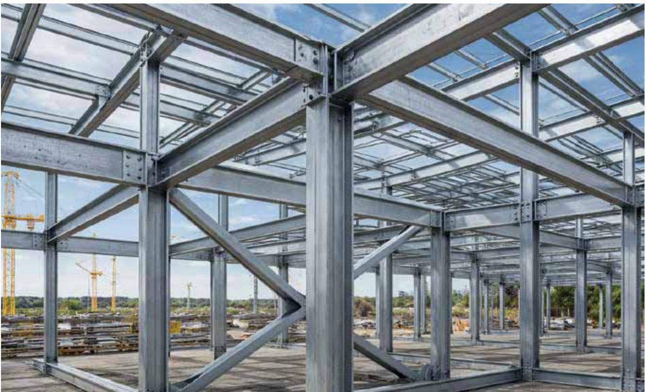
▲ Utilizzo su travi d'acciaio e carpenteria metallica
