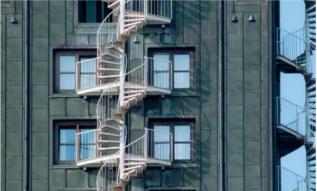
▲ Installazione di scale antincendio
