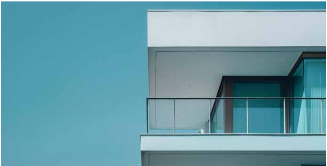
Installazione parapetti, ringhiere e serramenti
