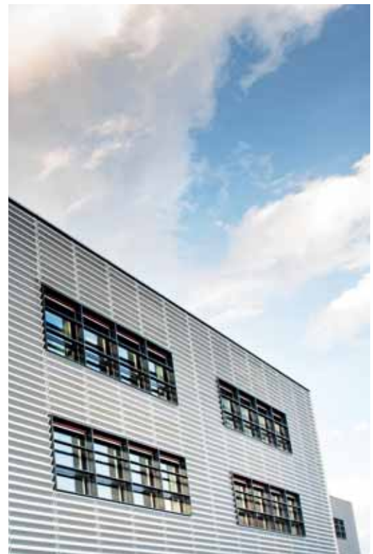
▲ Installazione di facciate ventilate
