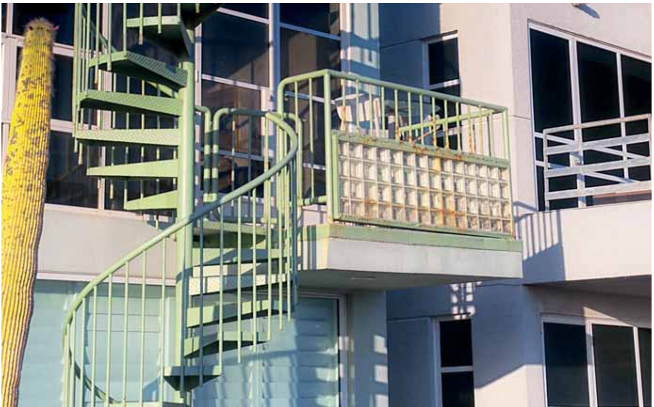
▼ Installazione di scale e parapetti
