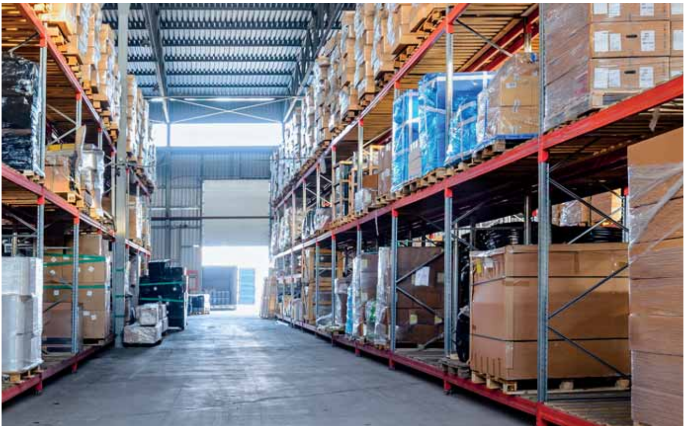
Installazione di scaffalature industriali
