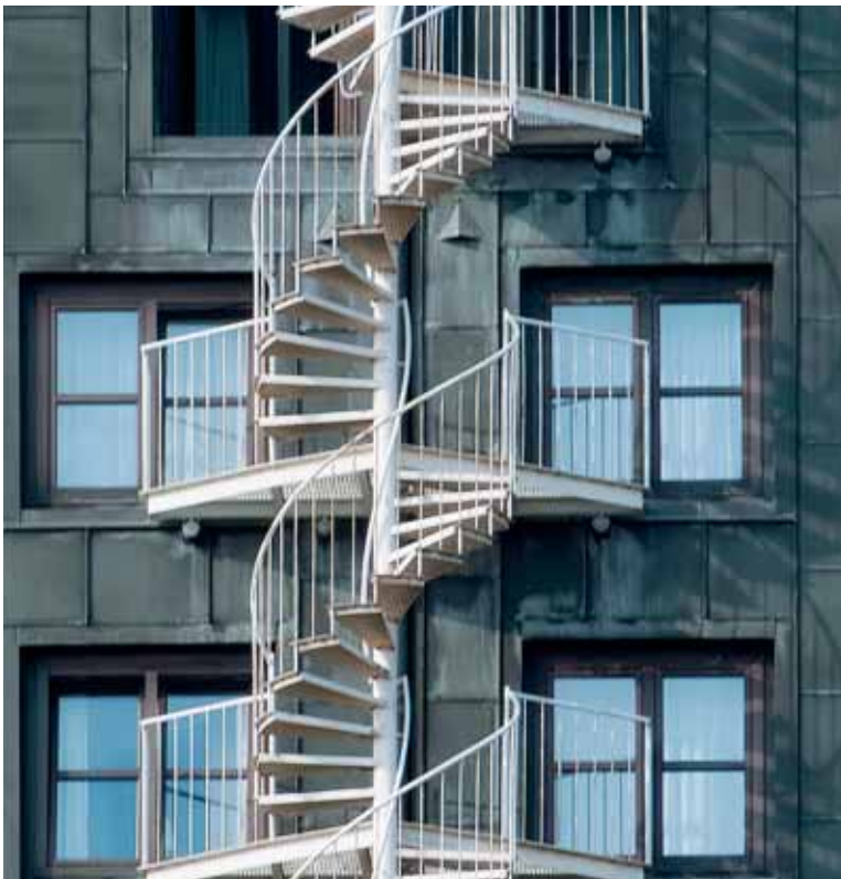
▲ Installazione di scale antincendio
