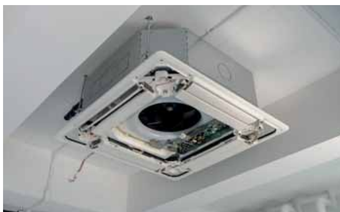
◀ Installazione distanziata di condizionatore a soffitto
