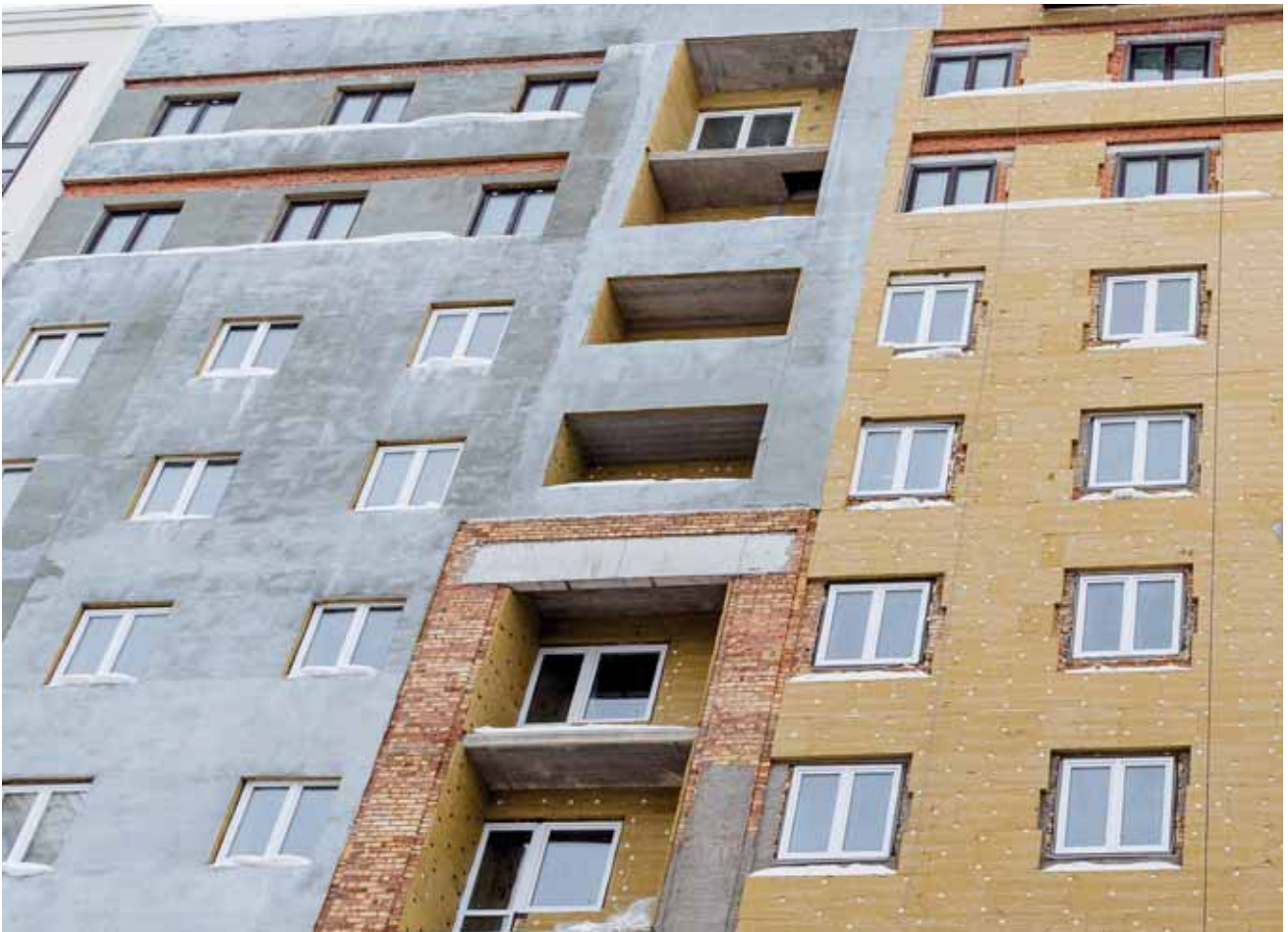
▲ Installazione di cappotto termico e sistemi di isolamento
